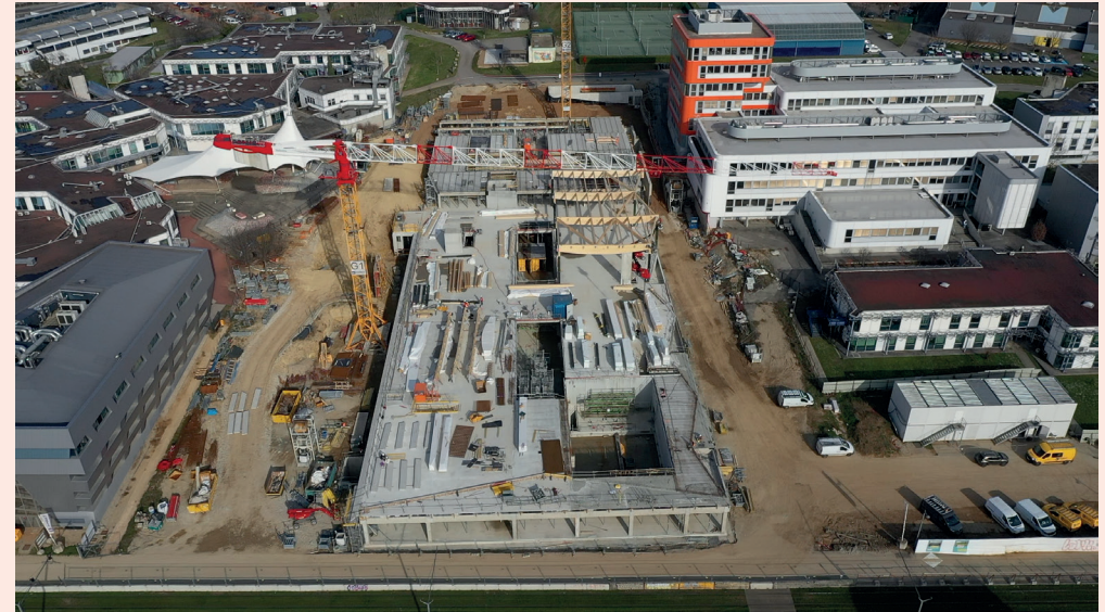
Chantier du Learning centre de la Ruche sur le campus Porte des Alpes
